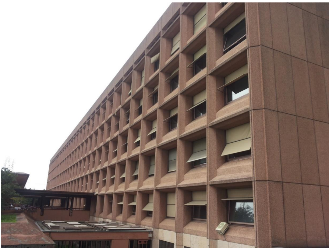
Figura 8 - Vista esterna del padiglione 1
