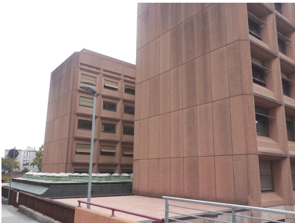
Figura 5 - Lato nord padiglione
