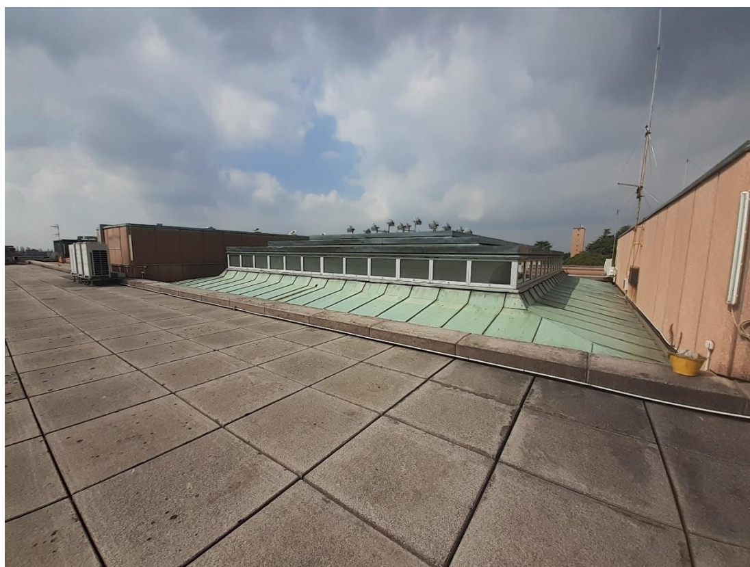
Figura 7 - Vista dalla copertura dell'atrio d'ingresso
