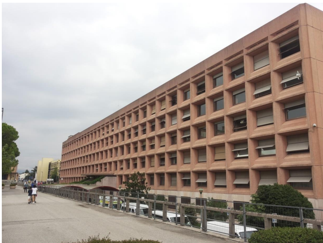
Figura 9 - Vista esterna del padiglione 1
