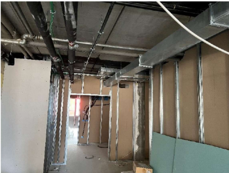
Foto 1 | Area di cantiere
