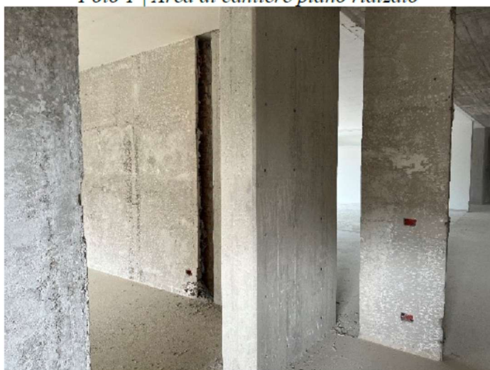
Foto 3 | Area di cantiere piano rialzato
