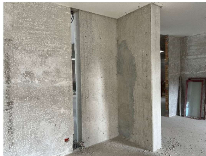
Foto 2 | Area di cantiere piano rialzato
