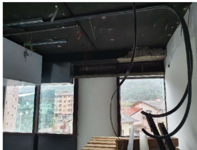
Foto 2 | Pannello provvisorio di chiusura facciata
