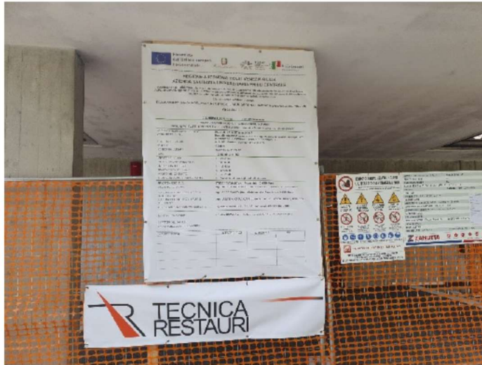
Foto 1 | Cartello di cantiere
