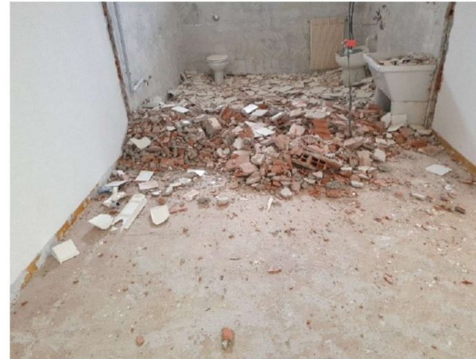
Foto 2 | Demolizioni tramezzi e rivestimenti in piastrelle
