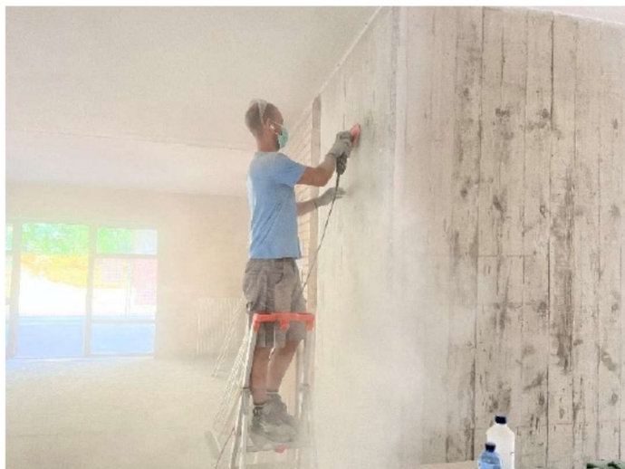
Foto 1 | Area di cantiere piano rialzato
