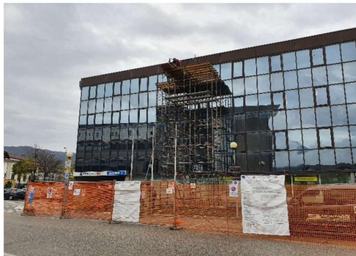
Cantiere COT e CdC
