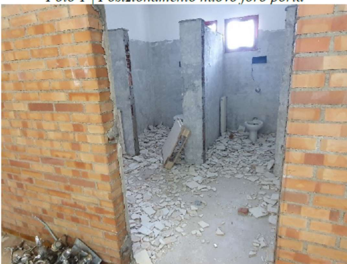
Foto 3 | Demolizioni rivestimenti in piastrelle
