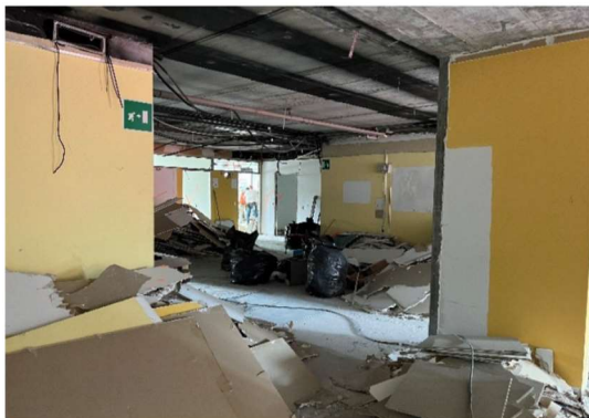
Foto 1 | Opere di demolizione
