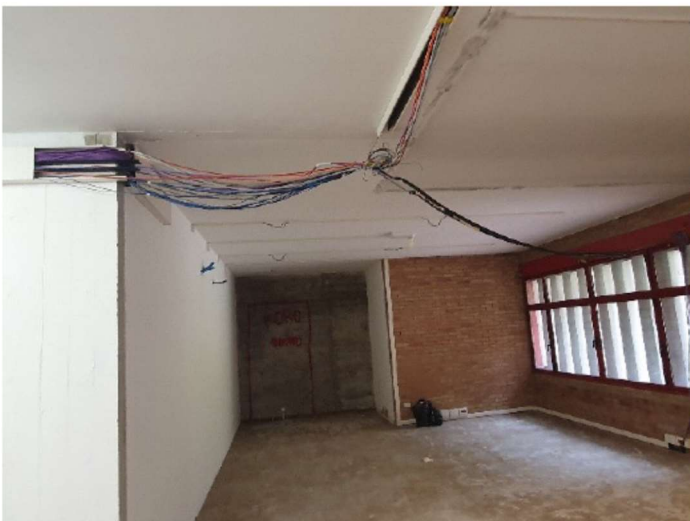
Foto 1 | Posizionamento nuovo foro porta
