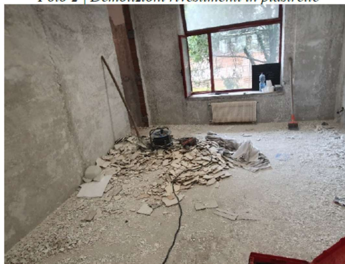
Foto 4 | Demolizioni rivestimenti in piastrelle
