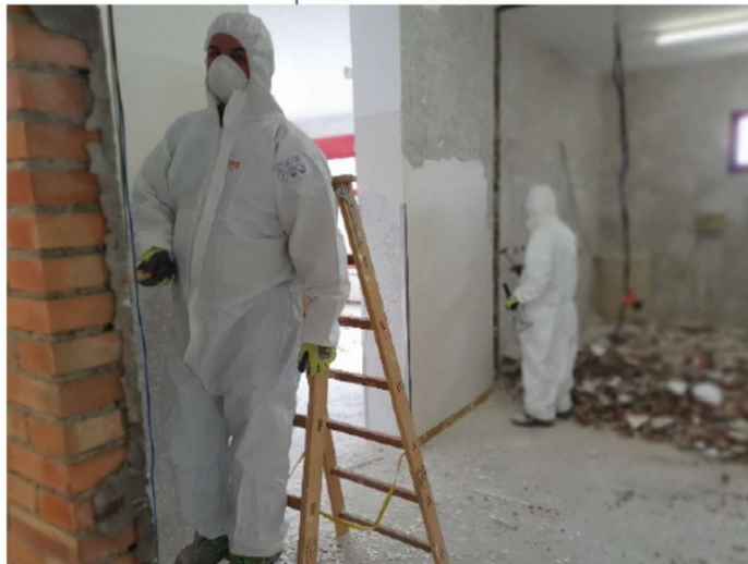
Foto 3 | Rimozione di pitture
