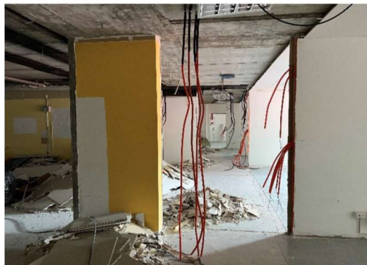
Foto 2 | Opere di demolizione
