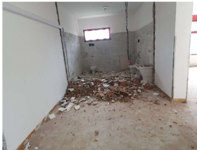
Foto 2 | Demolizioni rivestimenti in piastrelle
