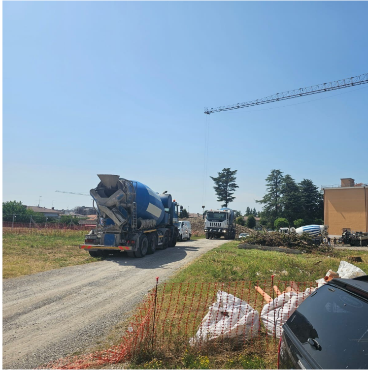
Immagine del cantiere
